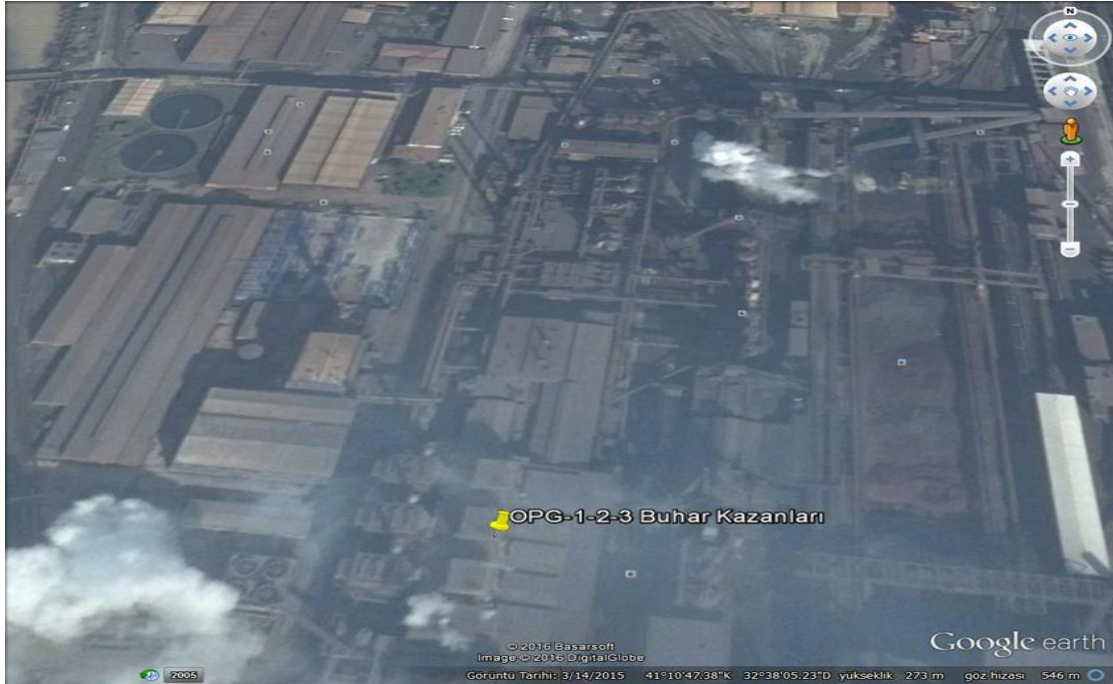
Şekil C.20 – Karabük İlinde Bulunan Termik Santrallerin Yeri (Kardemir A.Ş., 2017)
