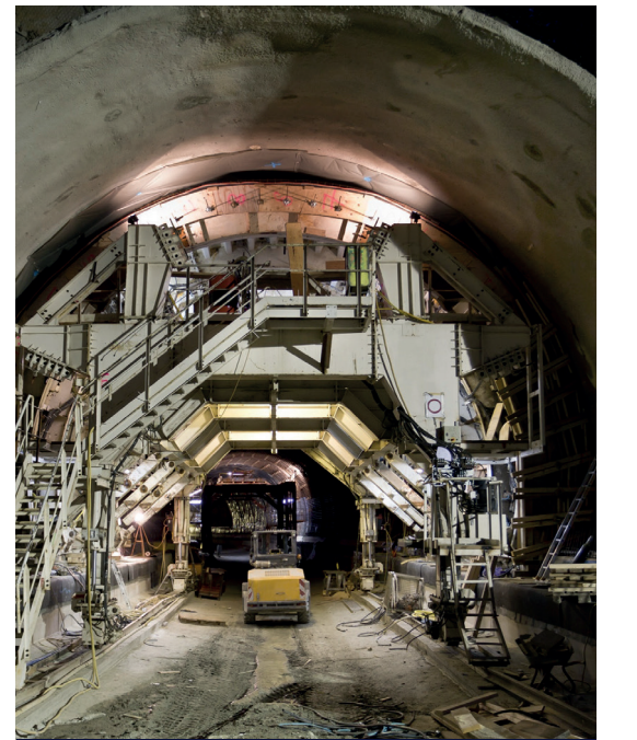
Grand Paris Metro İnşaatı
