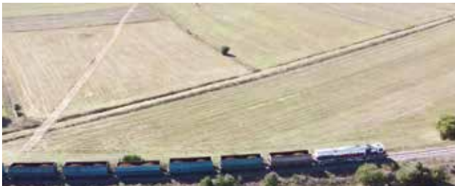
Eskipazar OSB'nin doğu cephesi boyunca mevcut olan demiryolu
